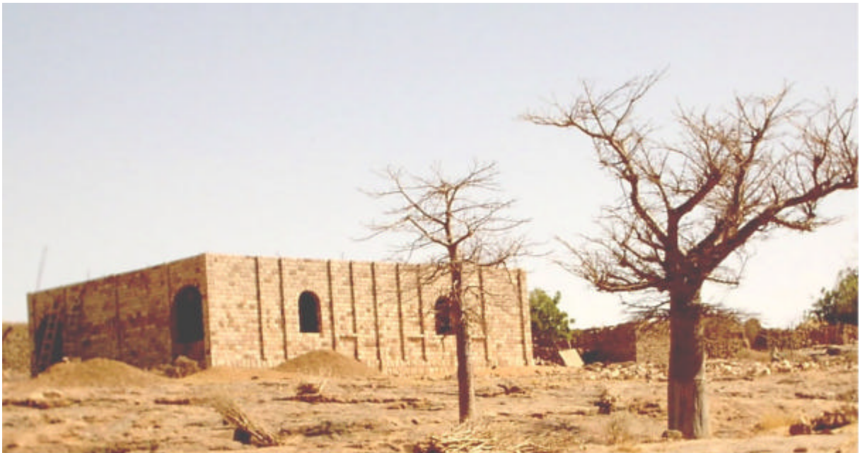
Eglise en construction
